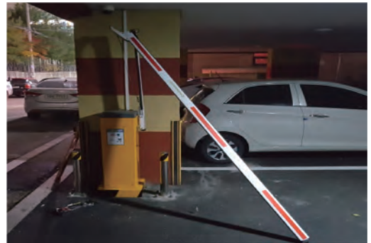
▲ Puerta de cruce dañada o destruida
